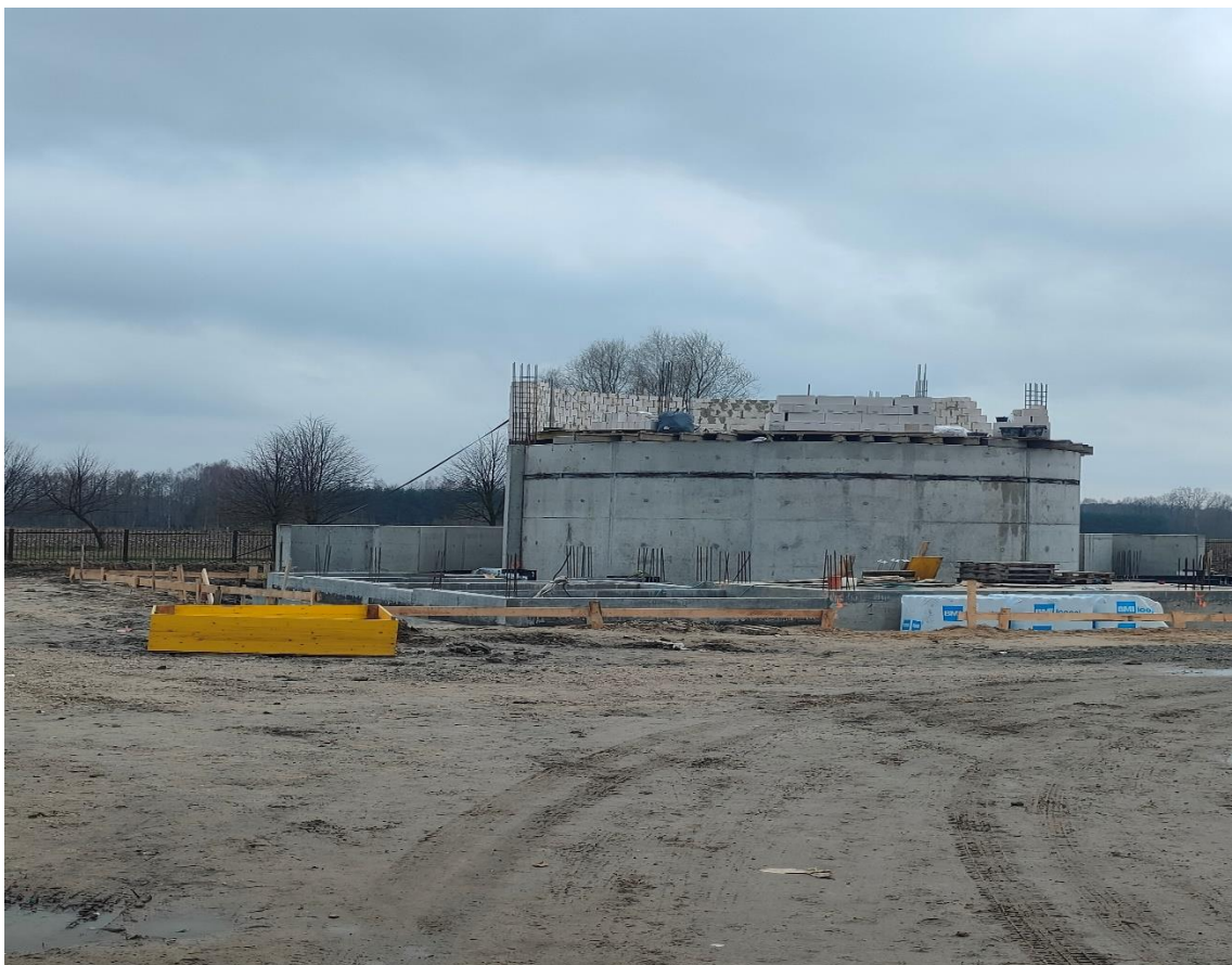
Zdjęcie nr 10: Budowa gminnej oczyszczalni ścieków w Ojrzeniu (fot. materiały własne)
